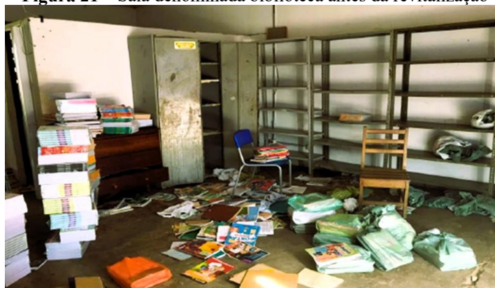
Figura 21 – Sala denominada biblioteca antes da revitalização
