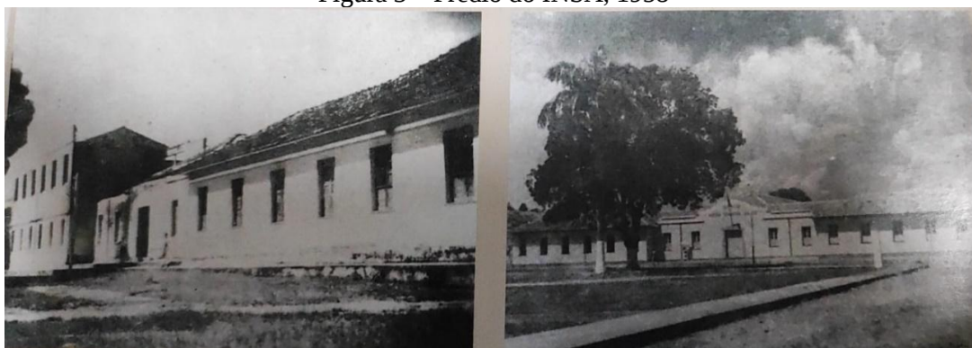
Figura 3 – Prédio do INSA, 1958
