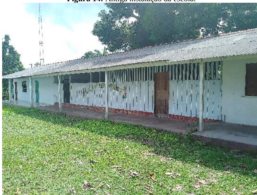
Figura 14: Antiga instalação da escola.
