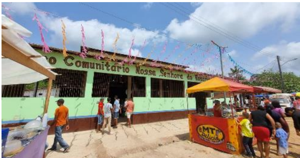
Figura 12 – Barracão comunitário Nossa Senhora do Rosário
